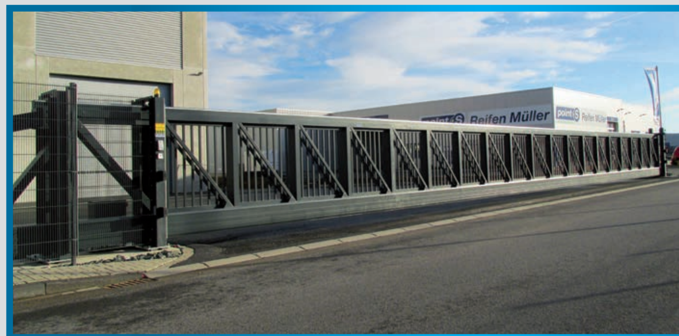
25 m Schiebetor mit Doppelaufschiene und 400 V Motor.
