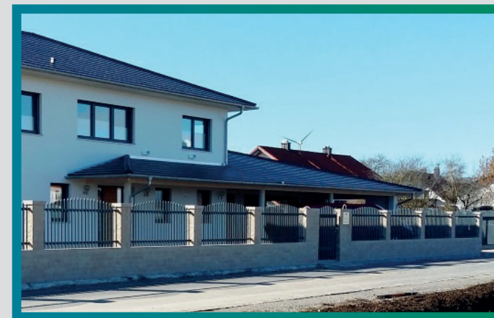
Paris Zaunfelder Konvex, Abschluss Spitzkappe, RAL 7016, montiert auf bauseitigen Mauern
