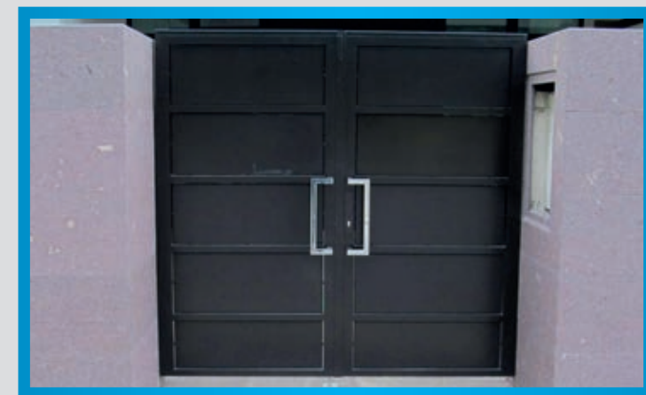
Gehtür 2-flügelig Kasette offen, RAL 8022 MATT, Montage zwischen bauseitigen Mauerpfosten
